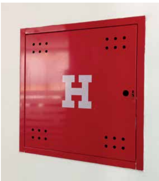
Unutrašnji hidrant
